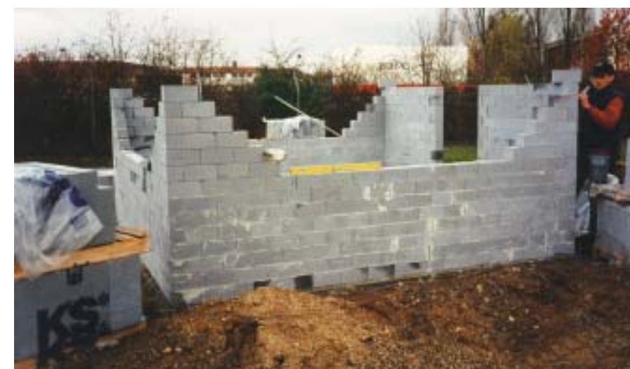
Bau des EMV-Testhauses aus KS protect®
