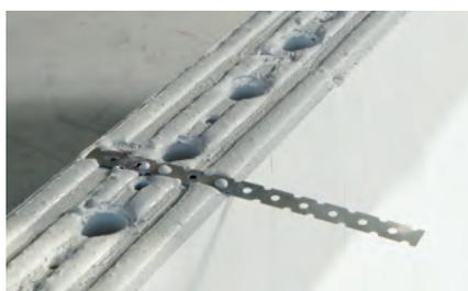
Stumpfstoßfuge vollflächig vermörteln.
